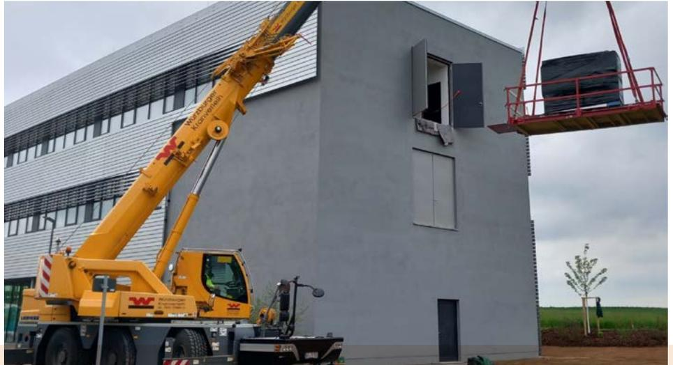
Die neue CT-Anlage wird mit einem Kran in das zweite Obergeschoss des SKZ-Gebäudes TZQ gehoben. (Bild: SKZ)
