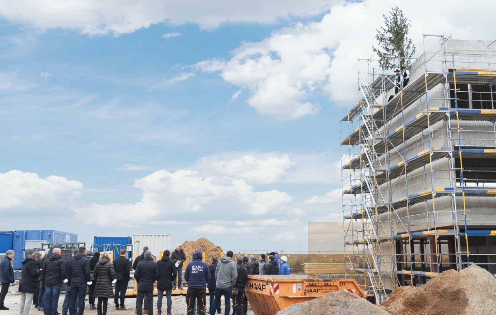
Das SKZ feierte am 26. November 2021 das Richtfest des Trainingszentrums Qualitätswesen (TZQ) im Würzburger Stadtteil Lengfeld. (Foto: SKZ)
