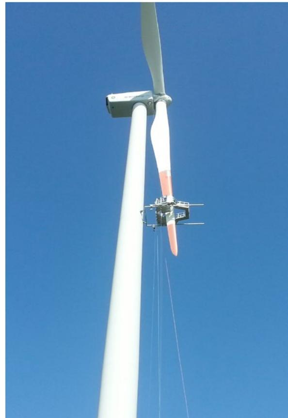
Die Rotorblätter gehören zu den am stärksten belasteten Bauteilen einer Windenergieanlage. Abhängig von der Intensität der Belastung sowie vom Verfahren und der Qualität des Fertigungsprozesses treten früher oder später Abnutzungsmängel auf.
